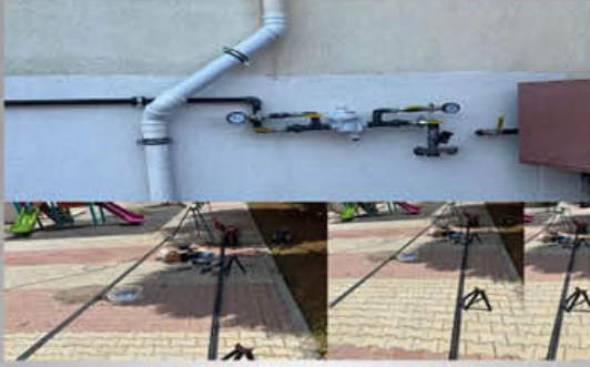
Anaokulumuza projeli doğal gaz hattı çekimi yapıldı
