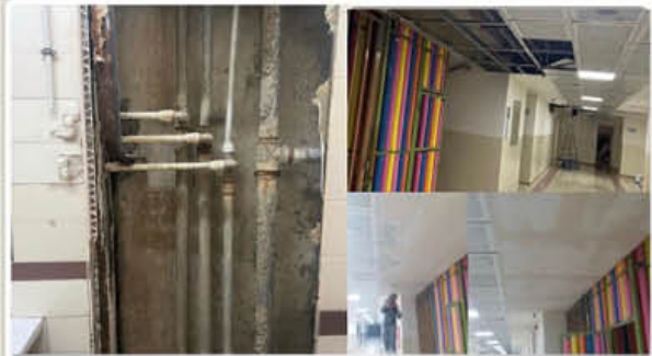
Okul su tesisatımızı tamamen yeniledik
