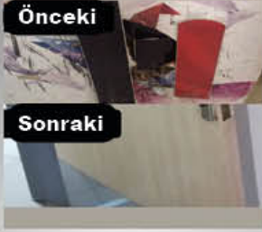
Kırık kapılar onarılıyor
