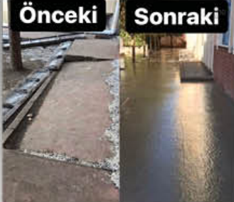
Okul bahçemizdeki çökmeler onarıldı
