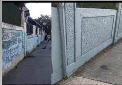
Okulumuzun dış duvarını boyadık
