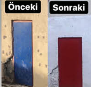
Acil çıkış kapılarımız onarıldı.
