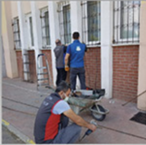
Giriş kat demir korkulukları yeniledik
