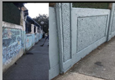
Okulumuzun dış duvarını boyadık
