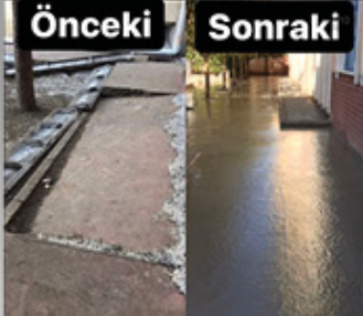
Okul bahçemizdeki çökmeler onarıldı
